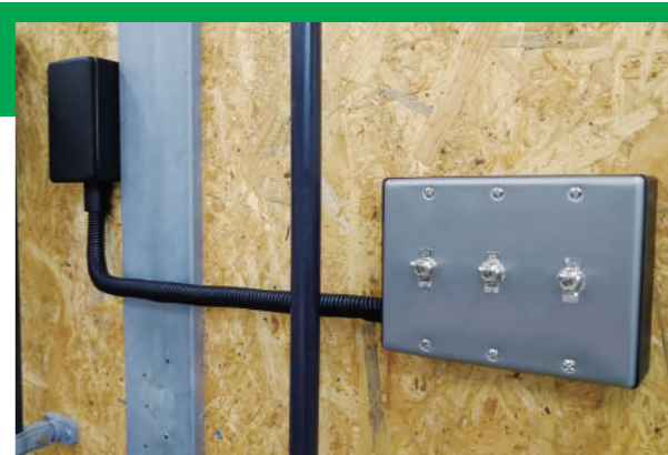
照明スイッチ移設工事
