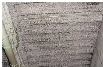
吹付け材 の例(床・天井)
